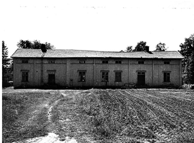
Manbyggningen på Grisbacka 5:16, numera kvarteret Tegen 14 i Umeå, byggdes med fyra tvärgående rumsavdelningar c:a 1779, förlängdes på östra gaveln c:a 1816 och byggdes på med några extra stockvarv på vinden 1896. Den revs 1970, då den ersattes med ett nytt stenhus i två våningar. Fotografi av Västerbottens museum 1970.
